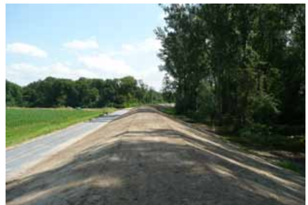
Deichausbau nach Profilierung und Einsaat
