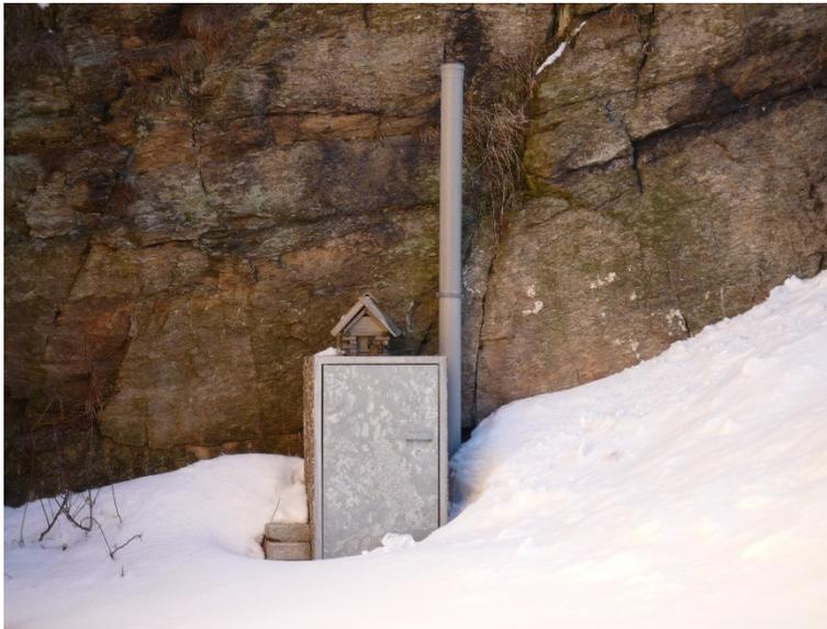
Ersetzen des belüfteten Deckels durch ein Belüftungsrohr
